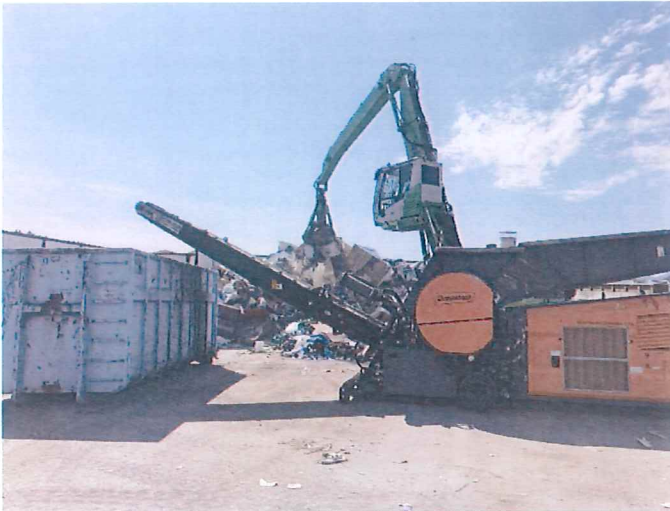
Slika: drobljenje kosovnih odpadkov z izločanjem kovinskih odpadkov
