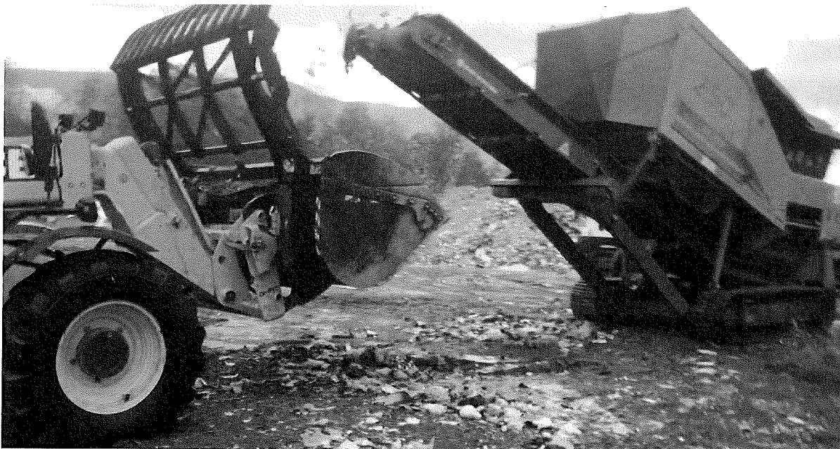
Slika: testno drobljenje kosovnih odpadkov z izločanjem kovinskih odpadkov
